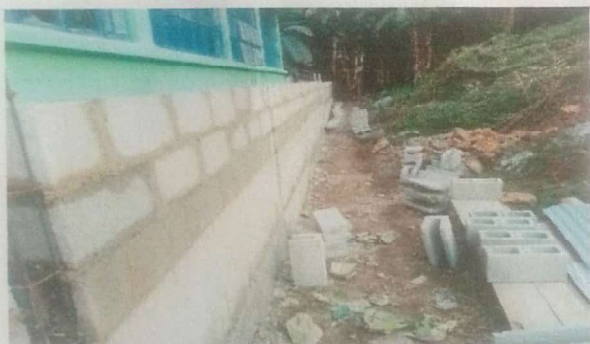
Foto 3: Armado y fundición de solera intermedia con block U
