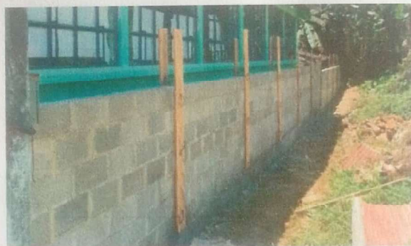
Foto 4: Finalización con Fundición de Columna y terminación con Solera block U en la cuarta hilada del muro.
