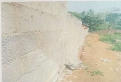
Foto 2: Finalización de Levantamiento de solera de humedad de concreto armado.
