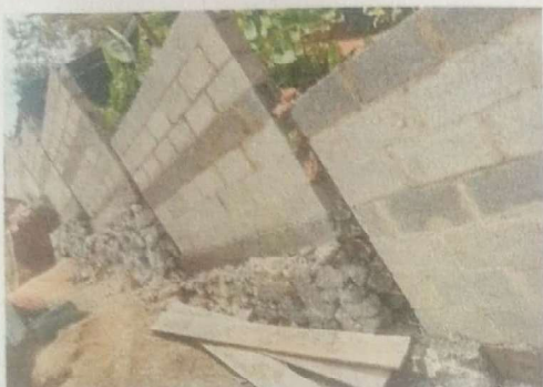
Foto 1: Levantamiento de muro de mampostería de piedra de corona por necesidad del terreno
