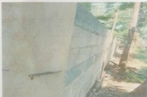
Foto 6: Finalización, con Fundición de Columna y terminación con solera de bolock U en la séptima hilada
